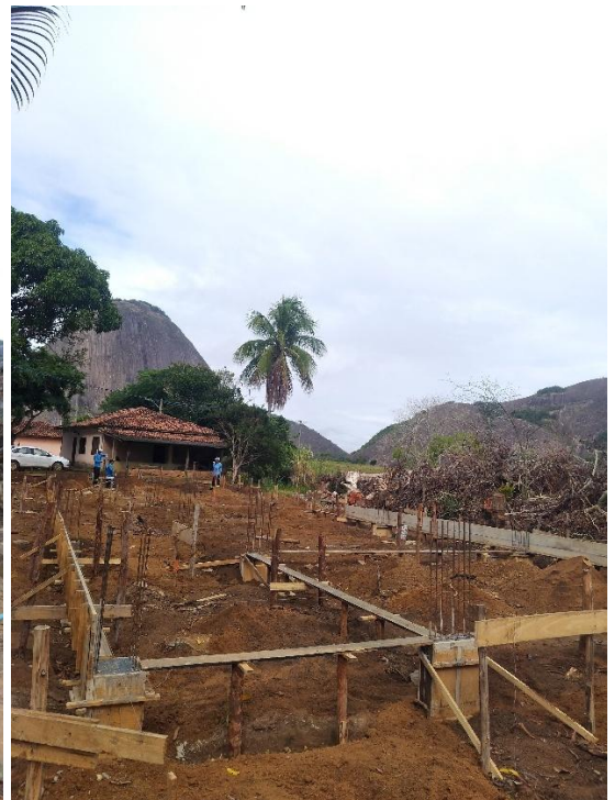
10 de maio de 2024 – vigas baldrames
