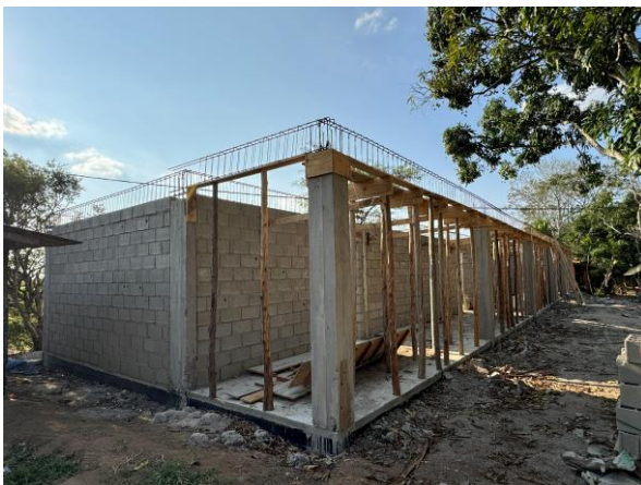
23 de agosto de 2024 – alvenaria e vigas aéreas
