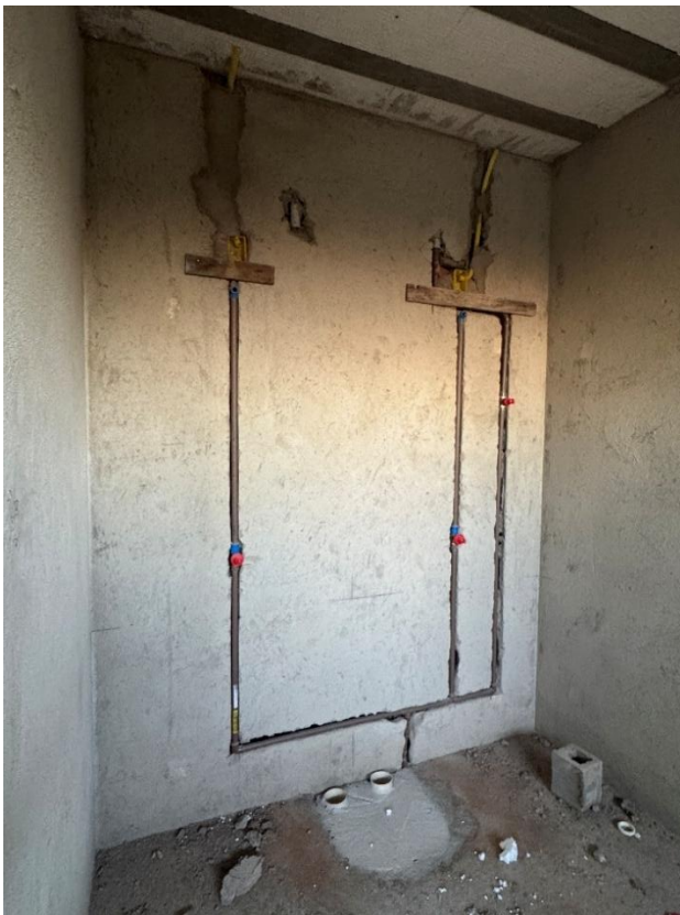
30 de junho de 2025 – início hidráulica
