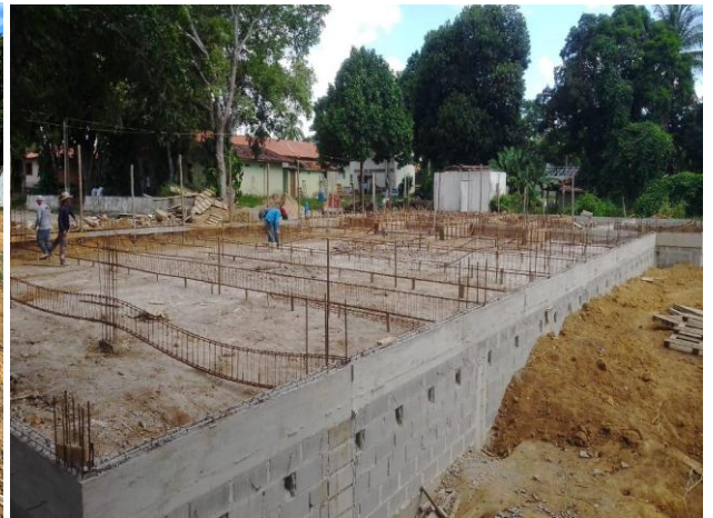
31 de março de 2025 – vigas baldrame
