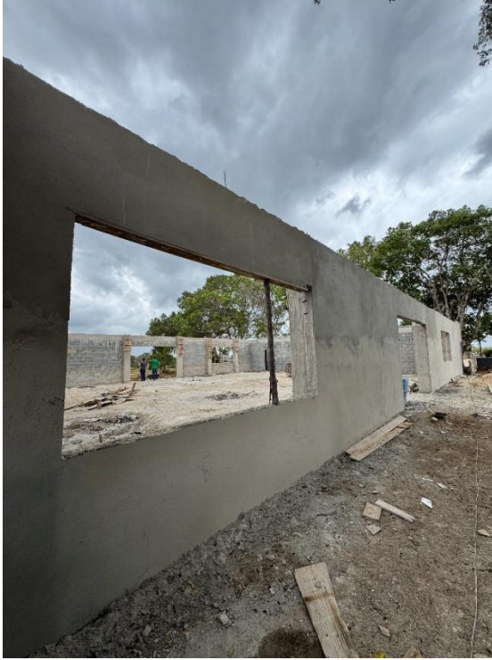
15 de outubro de 2025 – início reboco
