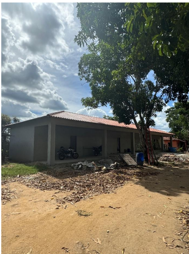
31 de março de 2025 – finalização reboco
