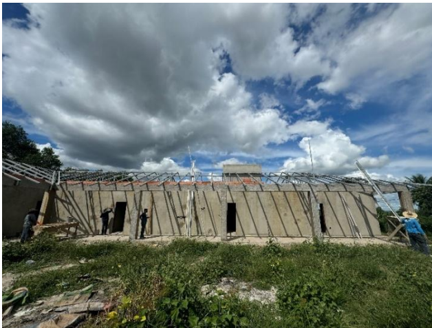
31 de março de 2025 – reboco externo e cobertura
