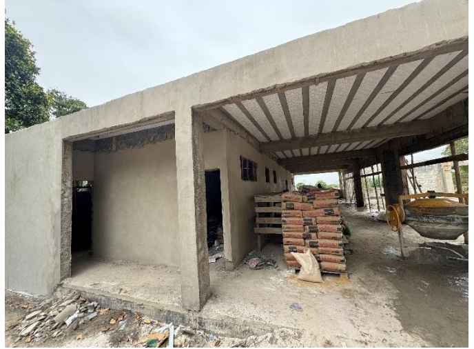
07 de novembro de 2025 – início reboco interno
