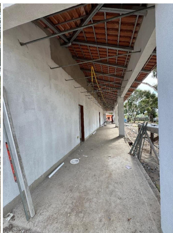
30 de julho de 2025 – selador, elétrica + estrutura forro
