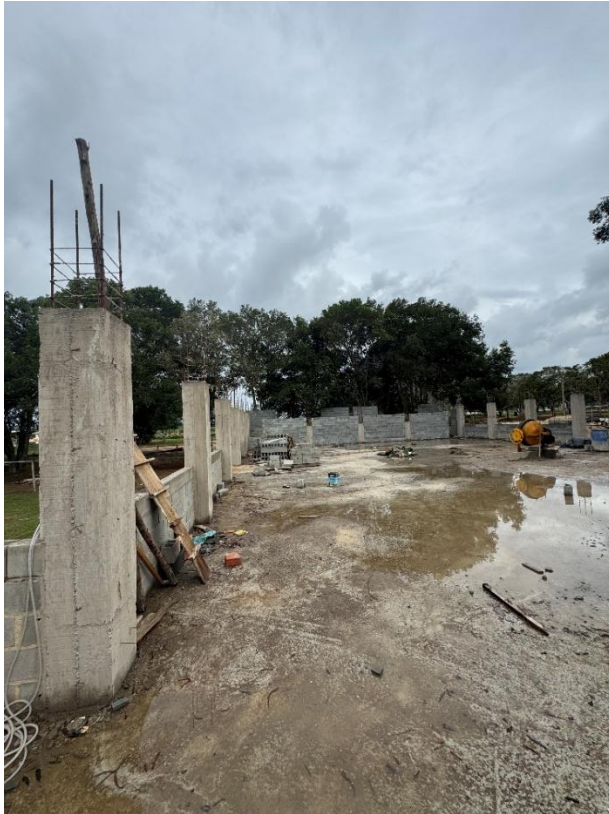
30 de maio de 2025 – pilares e alvenaria
