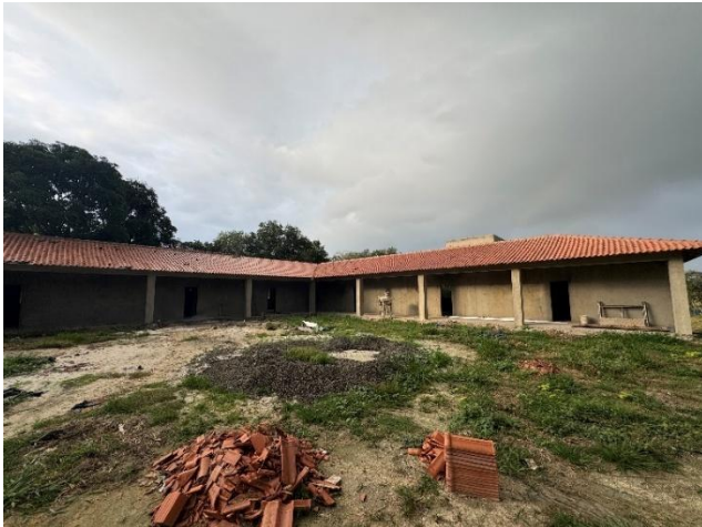
30 de maio de 2025 – instalação das telhas cerâmicas
