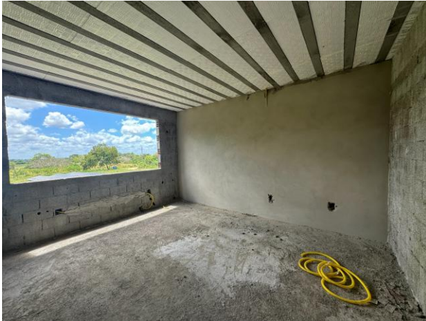
20 de janeiro de 2025 – reboco interno
