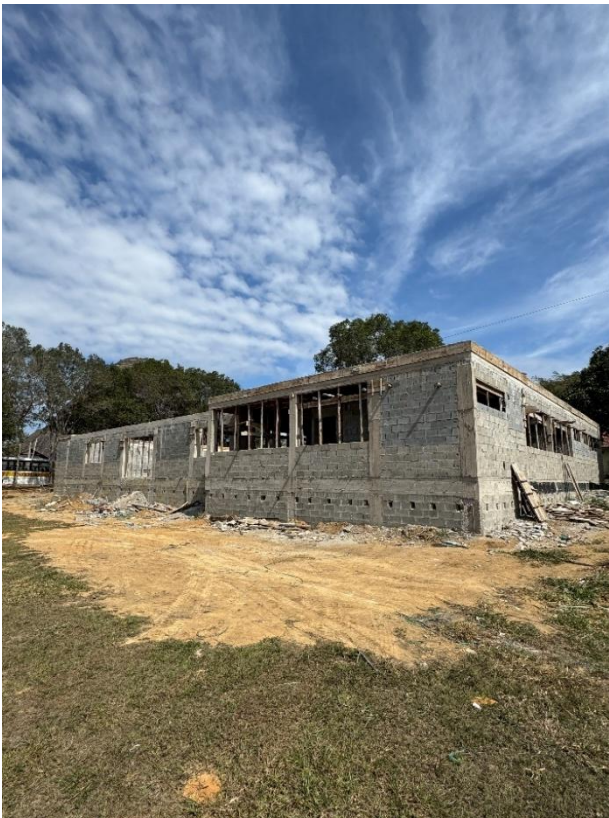
30 de julho de 2025 – laje cobertura
