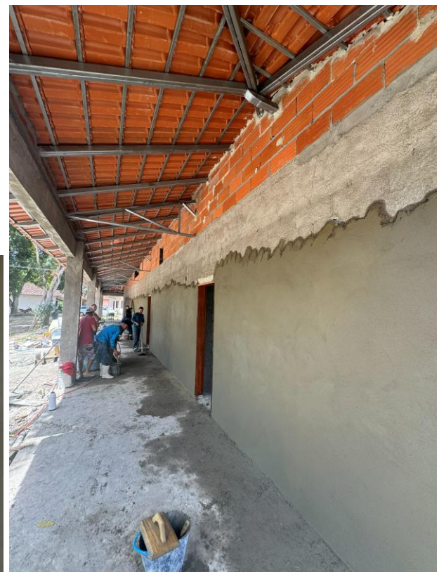
04 de fevereiro de 2025 – reboco externo
