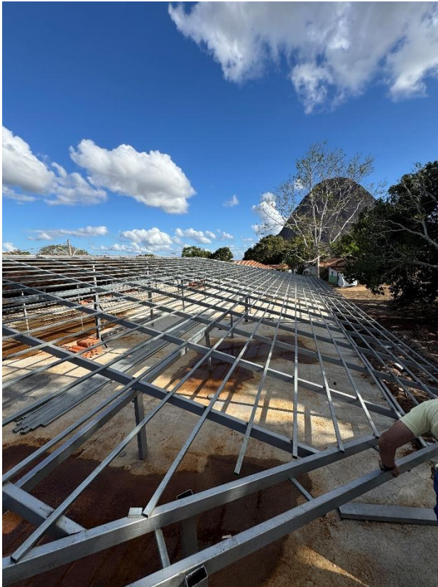
03 de setembro de 2025 – estrutura da cobertura
