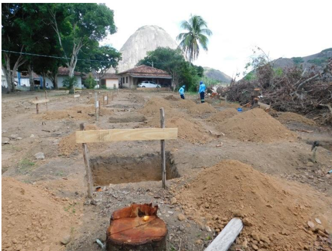
11 de abril de 2024 – início da fundação
