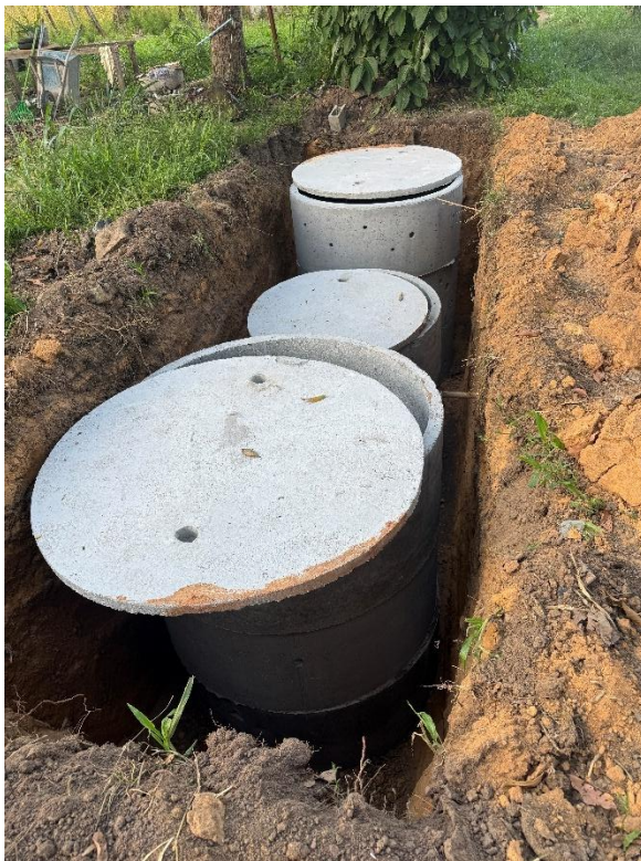
01 de dezembro de 2025 – início sistema de Fossa/filtro/sumidouro
