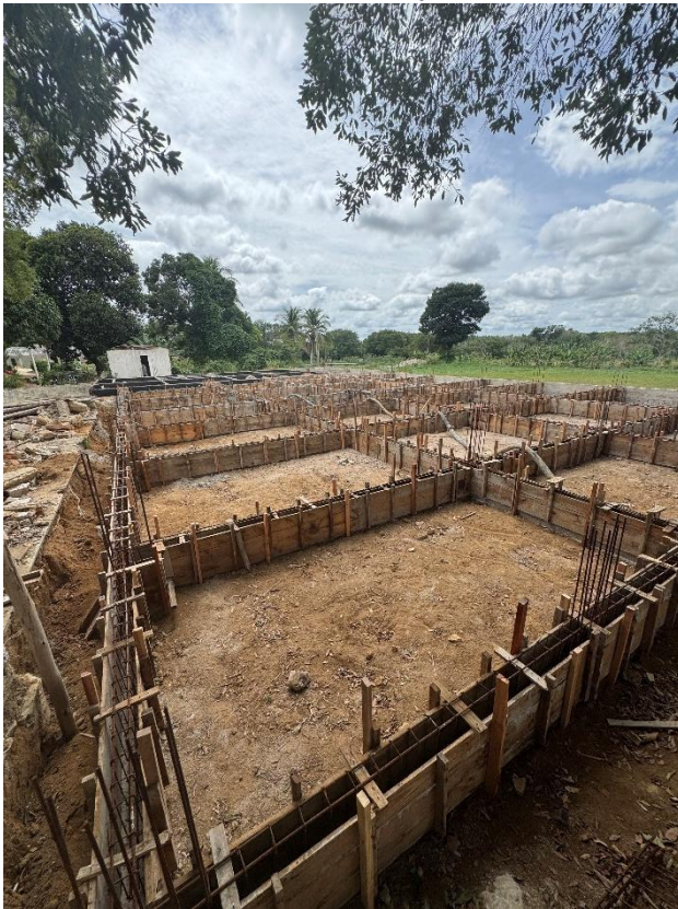
10 de abril de 2025 – vigas baldrame
