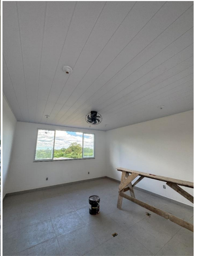
02 de fevereiro de 2026 – esquadrias
