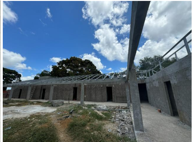
04 de fevereiro de 2025 – início estrutura do telhado
