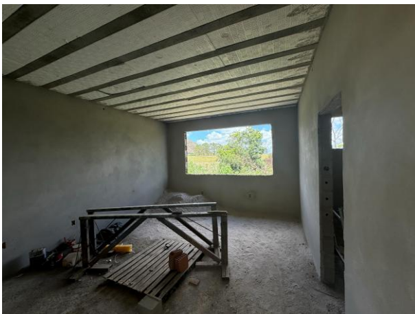
15 de janeiro de 2025 – reboco interno
