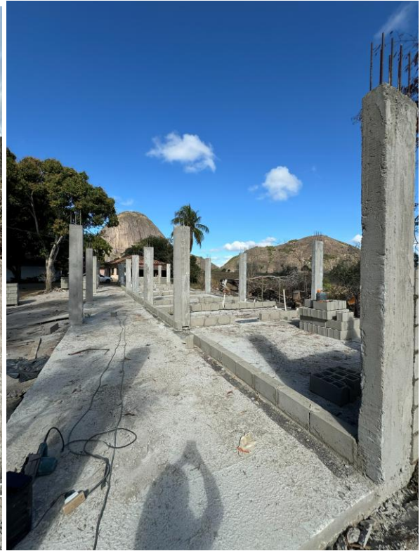
10 de julho de 2024 – laje piso + pilares
