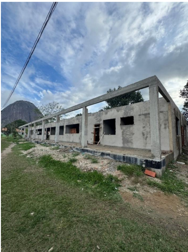
30 de maio de 2025 – reboco externo
