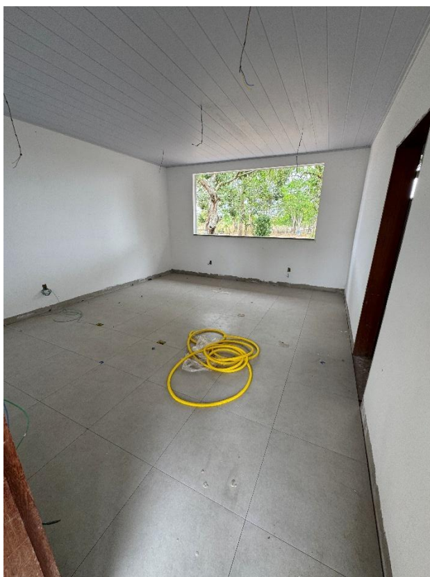
15 de outubro de 2025 – início assentamento do do piso
