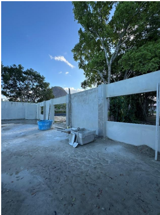
23 de dezembro de 2025 – continuação reboco interno
