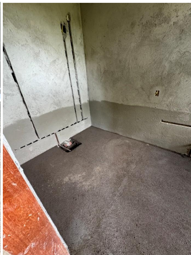
10 de abril de 2025 – contrapiso E continuação em maio de 2025
