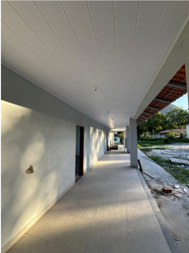
23 de dezembro de 2025 – assentamento piso
