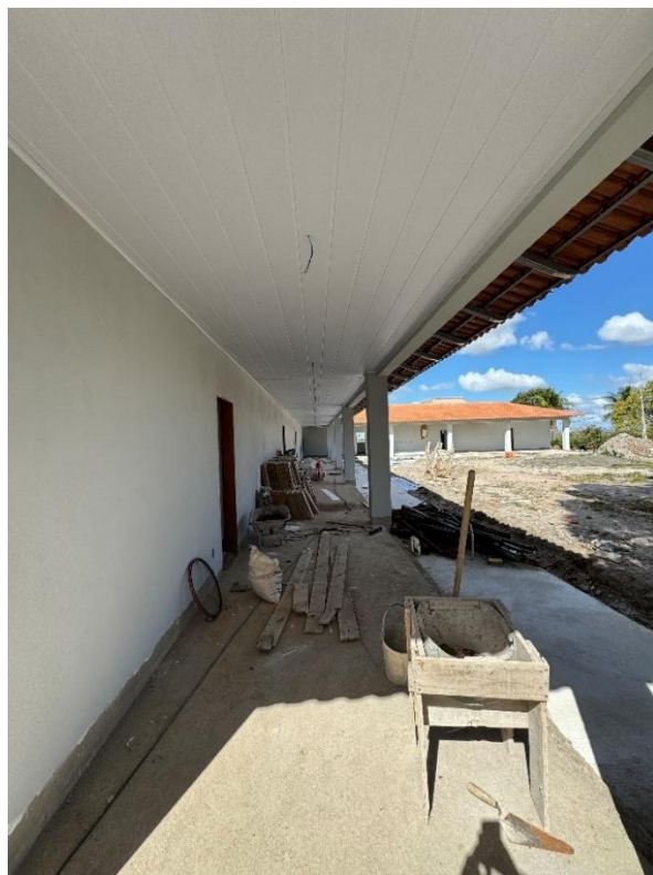
03 de setembro de 2025 – revestimentos, passagem cabeamentos e instalação do forro PVC
