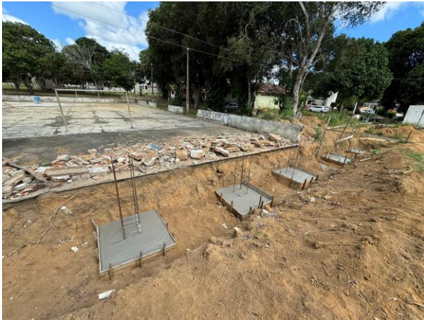
04 de fevereiro de 2025 – fundação
