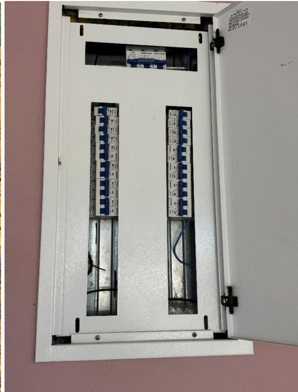
02 de fevereiro de 2026 – instalação disjuntores e pintura
