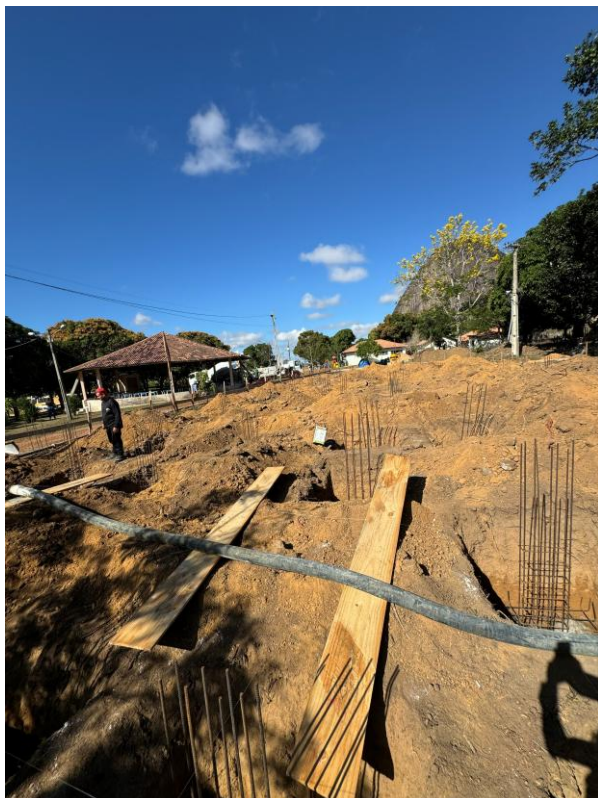
10 de julho de 2024 – início da fundação
