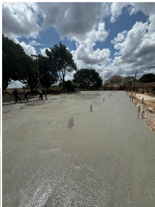
25 de setembro de 2024 – laje piso
