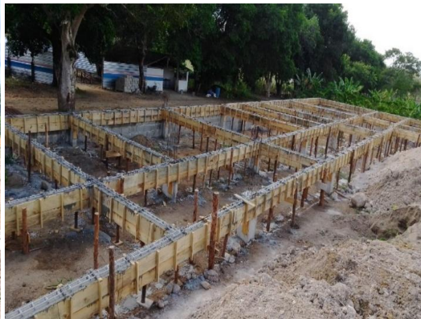
25 de abril de 2024 – execução vigas baldrame
