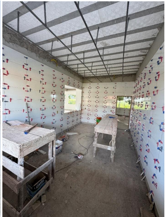
01/23 de dezembro de 2025 – emassamento externo e assentamento revestimento
