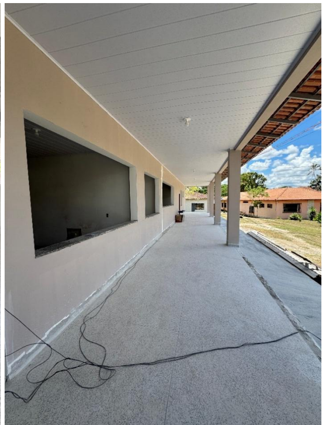
20 de fevereiro de 2026 – forro PVC, pintura e peitorils
