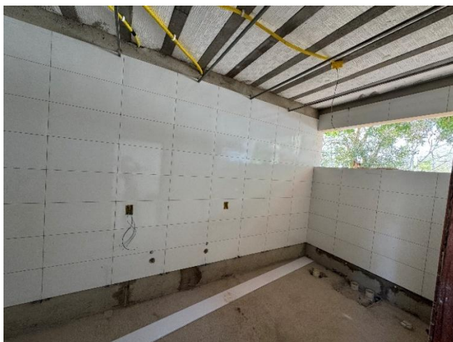
03 de setembro de 2025 – revestimentos, passagem cabeamentos e instalação do forro PVC
