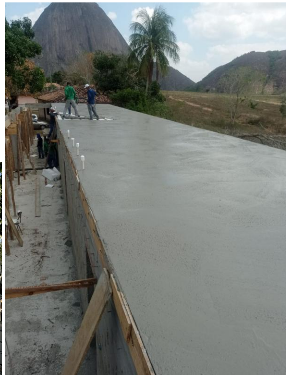
09 de setembro de 2024 – laje cobertura
