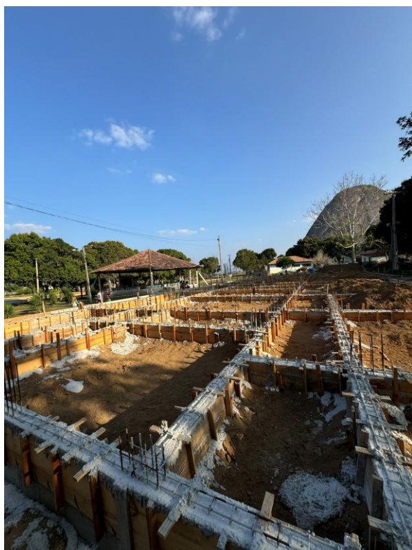
23 de agosto de 2024 – vigas baldrame
