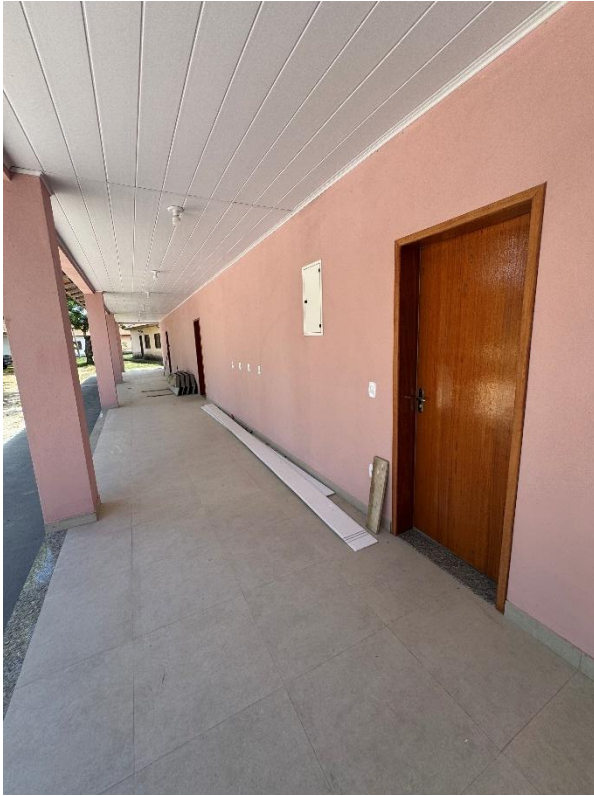
20 de fevereiro de 2026 – portas, soleiras
