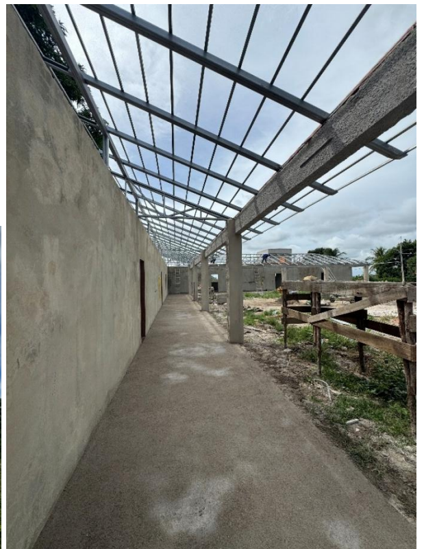
10 de abril de 2025 – contrapiso e cobertura
