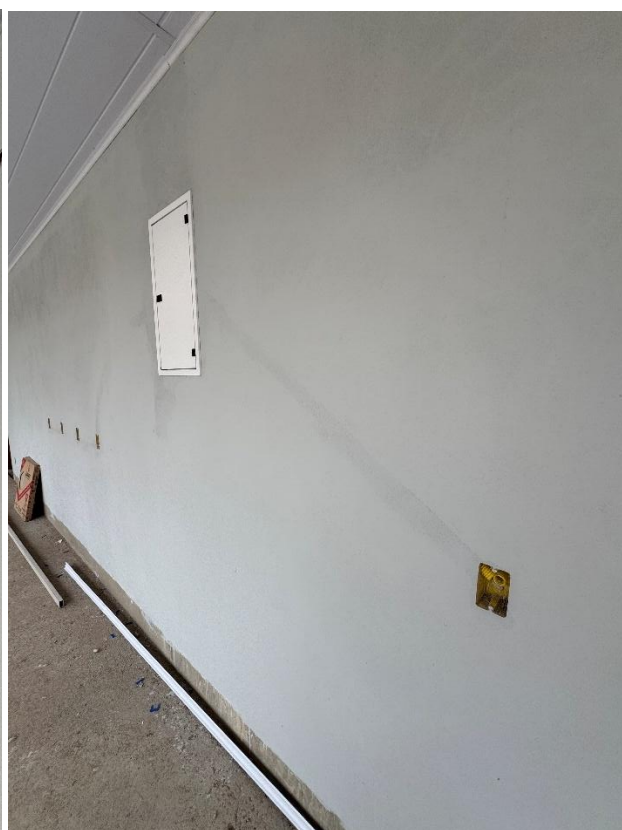
07 de novembro de 2025- 1ª demão pintura
