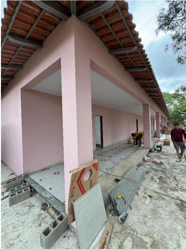
15 de outubro de 2025 – início assentamento piso e primeira demão de pintura.
