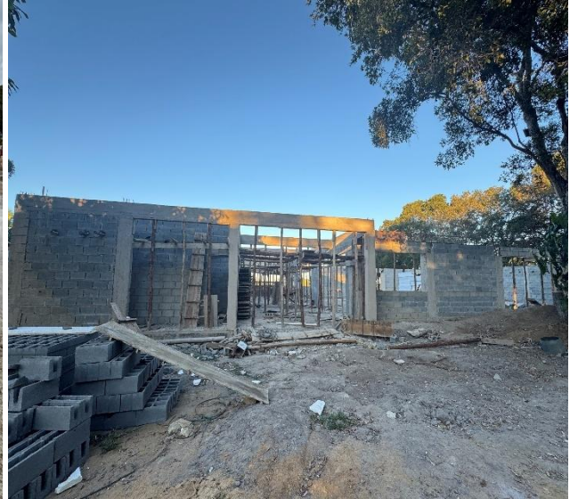
30 de junho de 2025 – alvenaria e vigas aéreas
