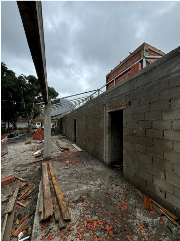
31 de outubro de 2024 – início telhado
