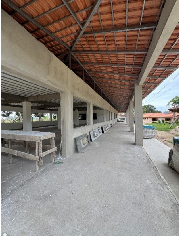
07 de novembro de 2025 – início emassamento e finalizando assentamento telhas cerâmicas
