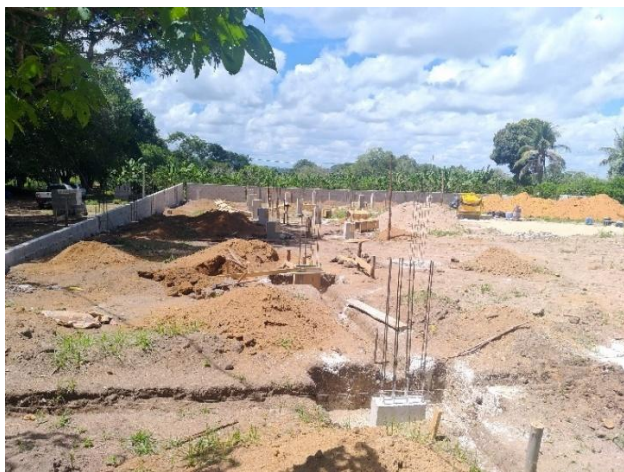
25 de março de 2024 – início da fundação
