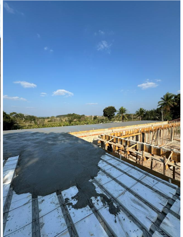
23 de agosto de 2024 – laje cobertura
