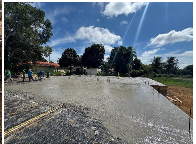
25 de abril de 2025 – laje piso
