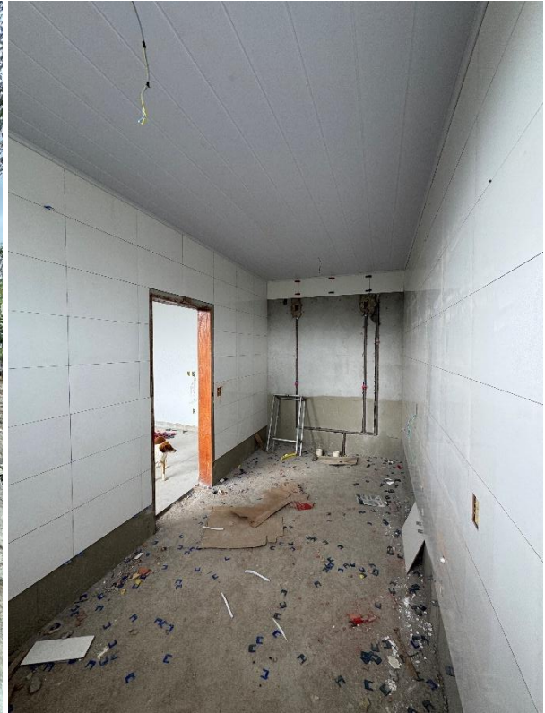
07 de novembro de 2025 – início assentamento de revestimento e hidráulica.
