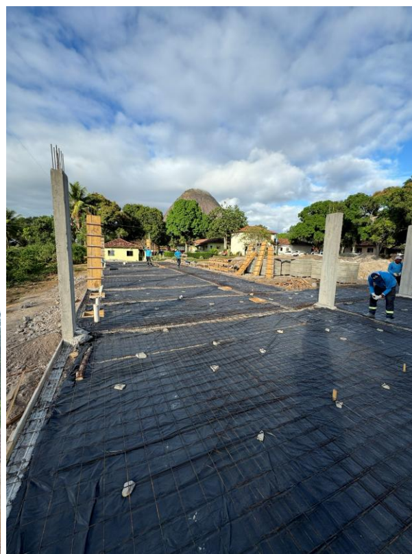
06 de junho de 2024 – laje piso e pilares
