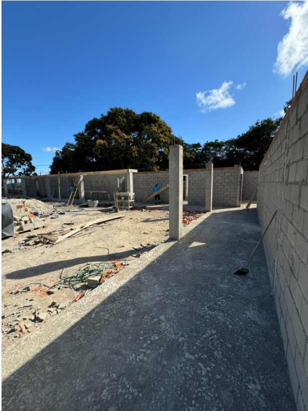
10 de julho de 2024 – alvenaria
