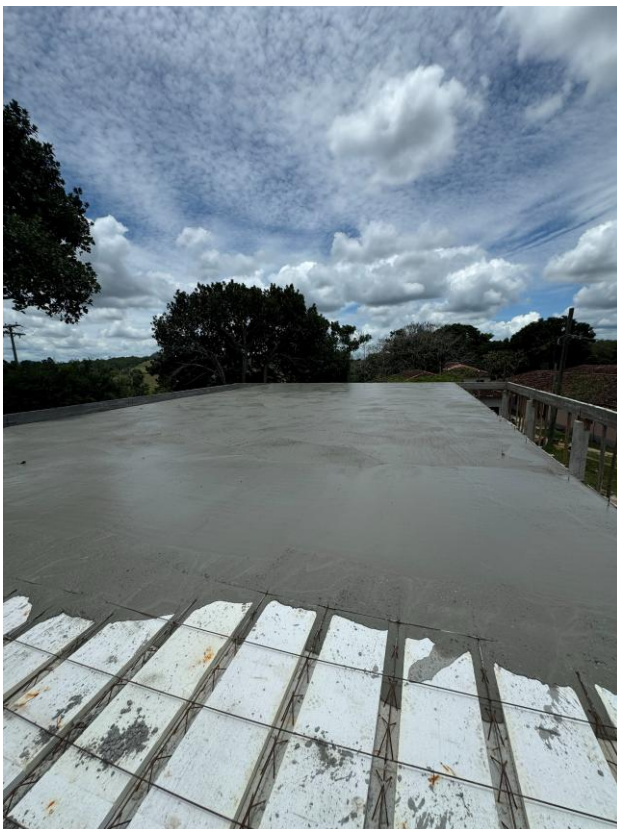
20 de dezembro de 2024 – concretagem laje
