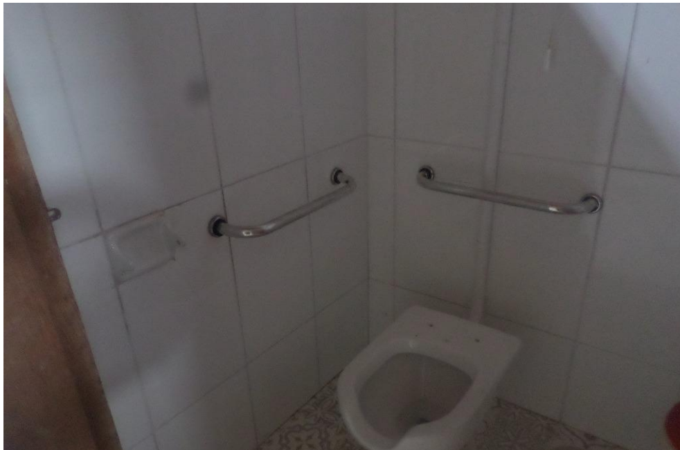
Imagem 6: banheiro com acessibilidade
